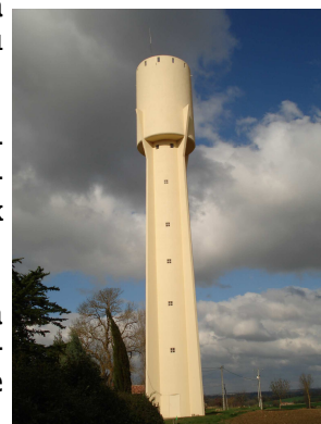
Château d'eau rénové de « Gaudoux » à PREIGNAN
