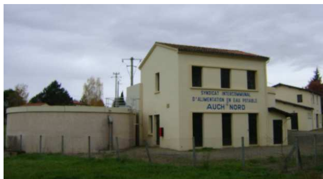
Station de pompage du Rambert.
