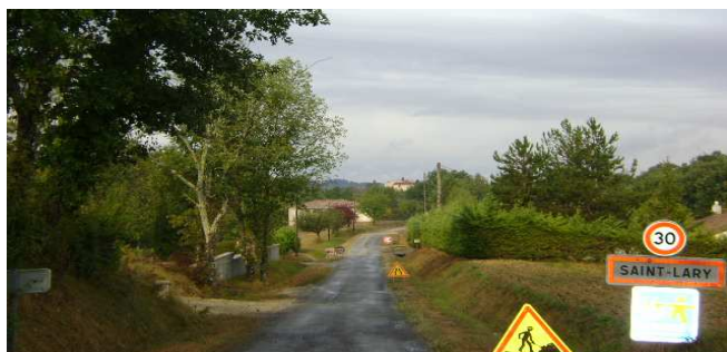
Chantier de renforcement d'eau en cours d'exécution.
